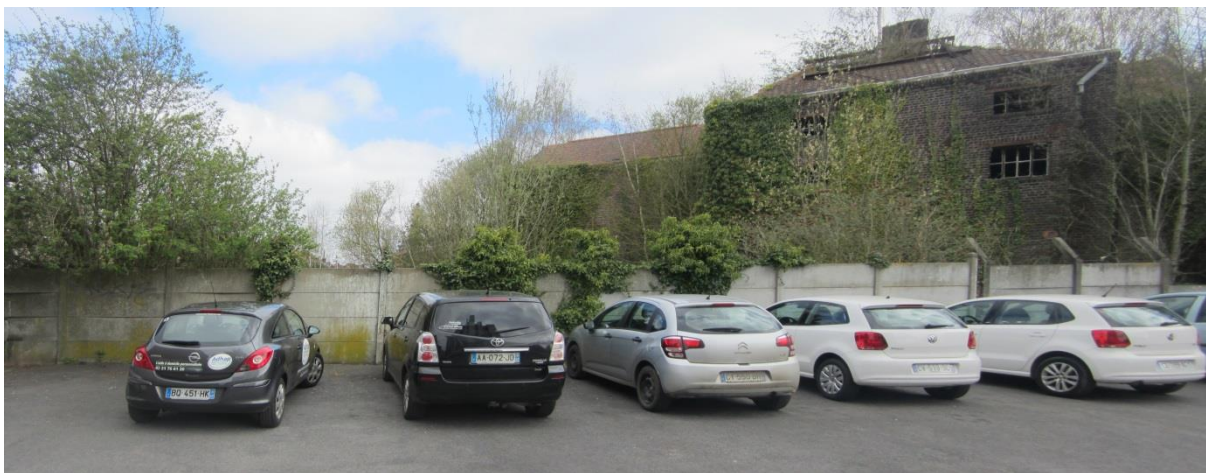
L'accès potentiel de la zone A depuis le parking de la rue A. Outrebon – la zone est en friche et possède d'anciens bâtiments à pouvant être démolis
