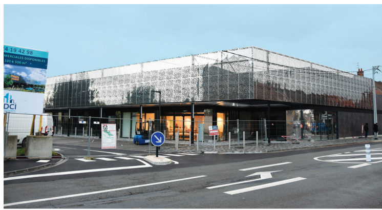
Le site a été entièrement refait pour offrir une structure moderne et lumineuse aux nouveaux commerces.
