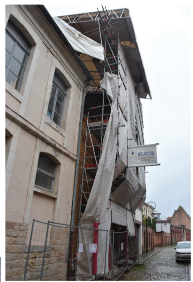
De grands échafaudages masquent la vue d'une des plus vieilles maisons de Béthune.
