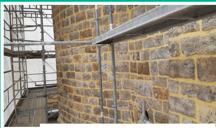
Toutes les pierres extérieures et intérieures de l'édifice ont été restaurées.
