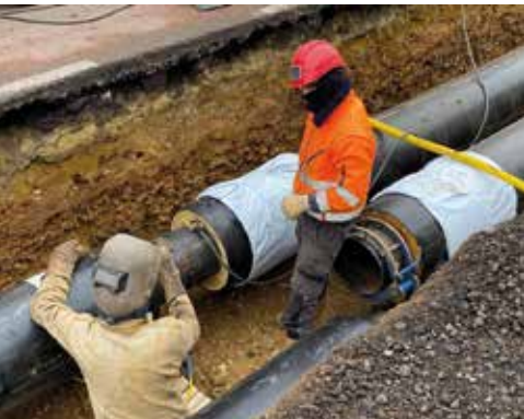
De nouvelles rues vont être concernées par les travaux du réseau de chauffage urbain.
