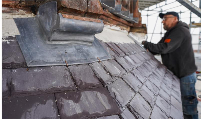
Les travaux de restauration de la charpente et de repose d'ardoises sont terminés.
