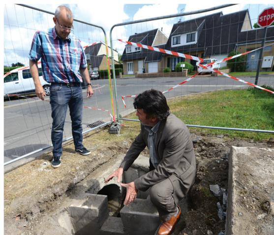
Installation d'un **limiteur de débit** et d'une pompe correctement dimensionnée dans la rue d'Hastings pour lutter contre les inondations
