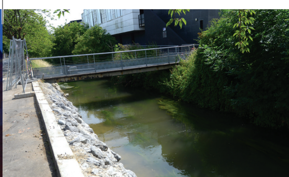
Renforcement de la berge, à proximité du centre aquatique, pour lutter contre les inondations
