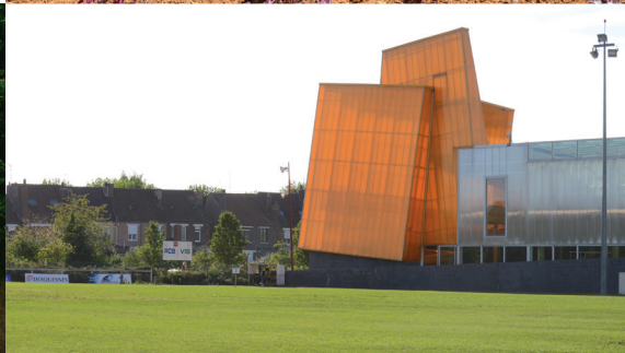
Remise en état du terrain Léo Lagrange avec la sécurisation du site, création d'un terrain d'entraînement en lieu et place de l'ancienne salle Léo Lagrange
