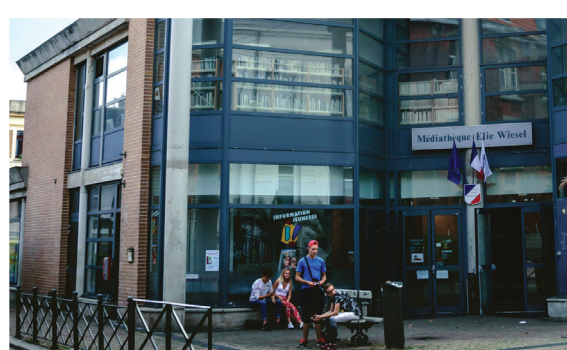
Démarrage du chantier de modernisation de la médiathèque Elie-Wiesel , avant sa transformation en tiers-lieu en 2019
