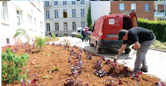
Réfection des abords de la Charité (pavés, plantations...) et travaux d'entretien au Foyer François-Albert (parquet de la salle vitrifié)
