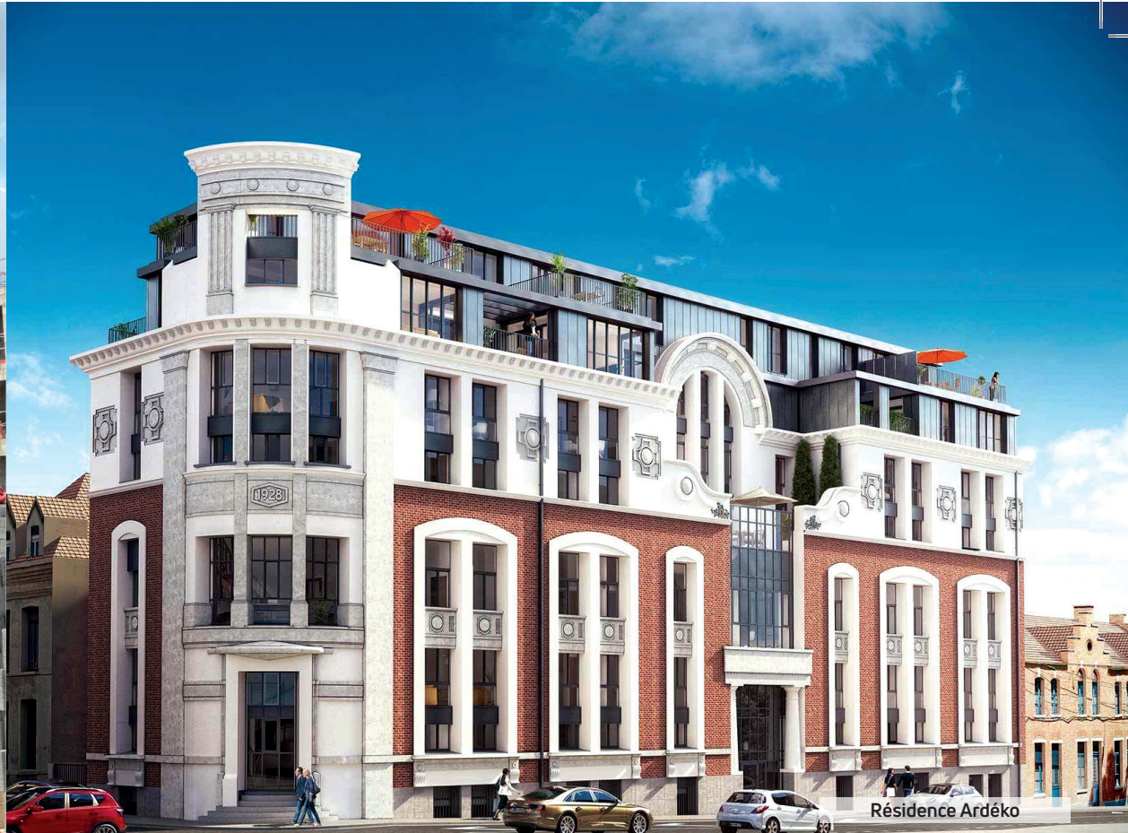
Logements rue du Rabat
